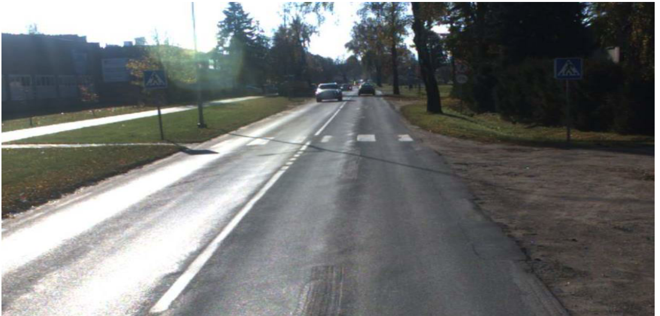
2 pav. Esama perėja ties 2,924 km (Klaipėdos g.)
